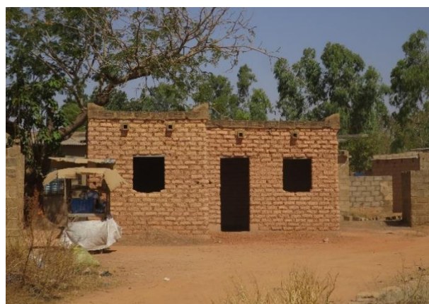
Maison en adobe en cours de construction à Ouagadougou – © Enrique Sevillano Gutiérrez, CRAterre
