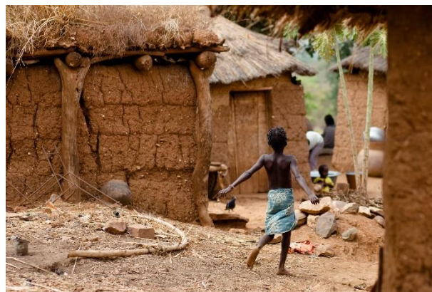
Maisons Lobi avec des murs en terre empilée et toitures plates en terre ou à quatre pentes en chaume (Région Sud-Ouest) – CC Eric MontfortPenot
