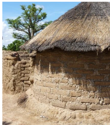
Maison ronde avec masse d'usure pour protéger la base du mur (Guiè, Région Plateau-Central) – © Sébastien Moriset - CRAterre
