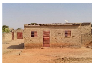
Les tôles, ouvertures métalliques et murs en parpaings contribuent à créer des intérieurs très chauds en journée, avec un inconfort thermique très important pour les habitants (Boassa, Ouagadougou) – © Enrique Sevillano Gutiérrez - CRAterre
