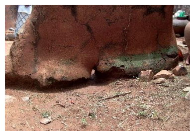
Les murs de terre requièrent à leur base soit un soubassement en matériaux non sensibles à l'eau, soit une masse d'usure suffisante, en plus d'un entretien régulier des abords et de la construction (Région Centre-Sud) – © Wilfredo Carazas Aedo - CRAterre
