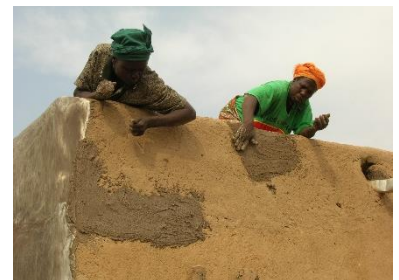
L'entretien périodique des murs (enduisage, rebouchage de fissure, entretien du pied des murs, entretien du côté exposé aux pluies battantes, etc., reste essentiel pour une durabilité accrue des constructions (Région Centre-Sud) – © CRAterre
