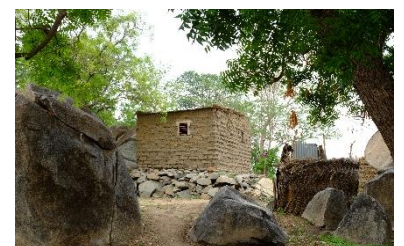
Fondations et soubassement en pierre à Kouro (Région du Boucle du Mouhoun) – © Nuria Sánchez Muñoz, CRAterre
