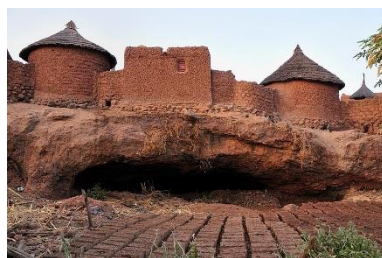
Les concessions fermées avec des murs d'enceinte et des murs des constructions opaques permettent de protéger les bâtiments des vents violents et des pluies battantes. De plus, les maisons groupées se protègent entre elles. Concession près du Mont Ténakourou (Région Cascades) – CC Sylvain Crouzillat
