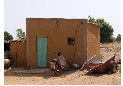
Le manque de fondations, de chaînage et de traitement des abords, les variations de teneur en eau du terrain, en plus du possible fait que le sol ne soit pas stable sont à l'origine de nombreux problèmes structurels dans les murs des maisons (Région Centre-Ouest) – © Olivier Moles - CRAterre
