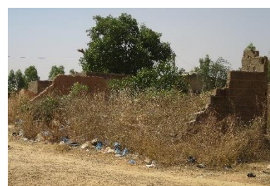
Des constructions de tous les types subissent les effets de l'instabilité structurelle à cause d'une mauvaise exécution et d'un entretien insuffisant (Ouagadougou) – © Enrique Sevillano Gutiérrez - CRAterre
