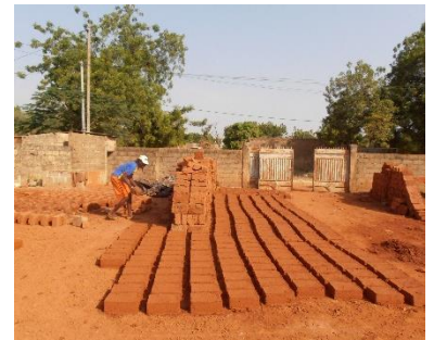
Production d'adobes à proximité des lieux de construction de logements (Fada N'Gourma, Région Est) – © Enrique Sevillano Gutiérrez - CRAterre
