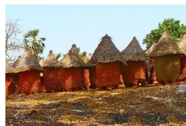
Dans certaines zones les greniers sont tous disposés à l'est des concessions (direction de provenance des vents dominants) pour éviter la possibilité de propagation vers les greniers des incendies qui pourraient surgir dans les cuisines (Greniers Sénoufo – Régions Hauts-Bassins et Cascades) – CC Rita Willaert
