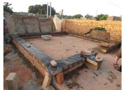
Cette maison (dont les murs seront en adobe) a une fondation en blocs de ciment pleins, plus une plateforme surélevée par rapport au terrain environnant, plus un soubassement en blocs de ciment pleins et une barrière capillaire en film polyané pour éviter les remontées capillaires dans les murs en adobe (maison à Fada N'Gourma, Région Est) – © Enrique Sevillano Gutiérrez, CRAterre
