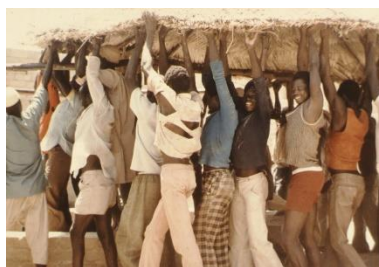
Travail communautaire pour le déplacement et la pose d'une toiture en chaume dans les années 1980 – © Belmans, CRAterre
