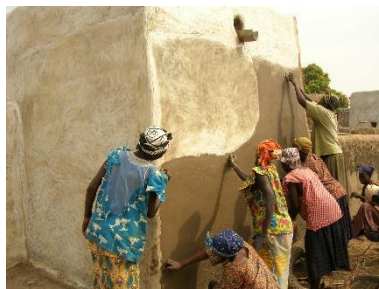
Travail communautaire des femmes Kassena pour la réalisation d'enduits de finition (Tiébélé, Région Centre-Sud) – © CRAterre
