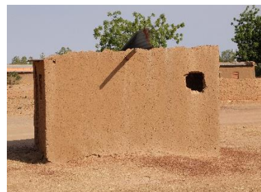
Les forts vents arrachent les toitures en tôle qui ne sont pas mise en œuvre dans les règles de l'art, dont leur débord fait face aux vents dominants, qui ne sont pas bien ancrées à la structure, etc. (Région Centre-Ouest) – © Olivier Moles - CRAterre
