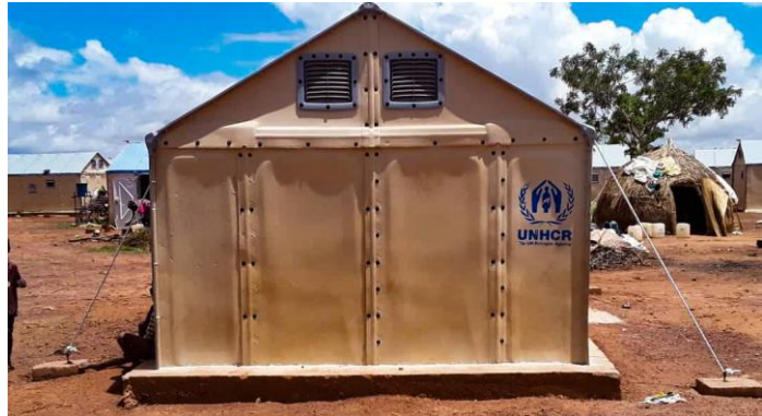
Renforcement des RHUs, sept. 2020. Nord. Photo UNHCR
