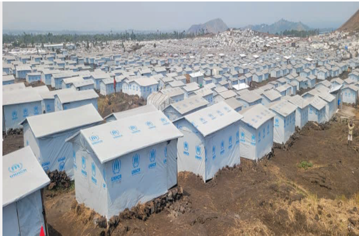
Constructions d'abris réalisées par le HCR et ses partenaires dans un camp de déplacés, dans le cadre de la réponse d'urgence à la crise humanitaire à l'est de la RDC, dans la province du Nord-Kivu.
