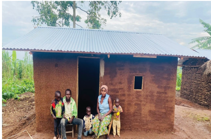
Construction d'abris réalisée par ADSSE avec le financement du Fonds Humanitaire, dans le cadre de la réponse humanitaire dans les zones de santé de Komanda et Rethy,
