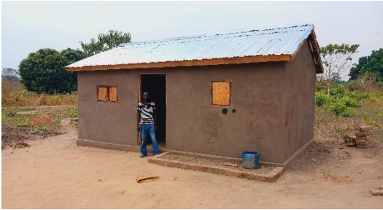
Abri de retour à Kaqa-Bandoro en tôle
