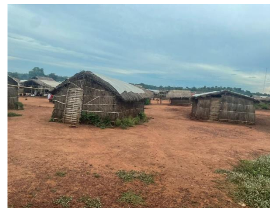
Abri d'aménagement réalisés par les PDI eux-mêmes sur le site MINSUCA PK8 (Bambari)
