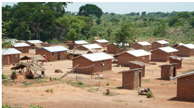
Construction d'abris de retour par OIM à Bambari pour relocaliser les PDI du site Minusca PK8
