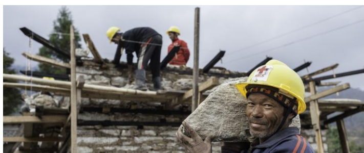
Des ouvriers du bâtiment construisent une maison pilote dans le village de Suspa Chhemawati, dans la région de Dolakha au Népal. Mention de source : Carlo Heathcote, FICR
