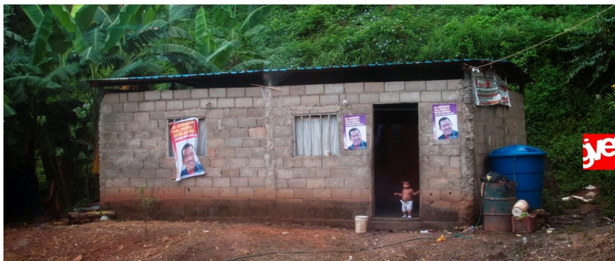
Vivienda rural de mampostería de bloques de cemento-arena, sin estructura portante de concreto. Estado Guárico. CC Eduardo Regalado
