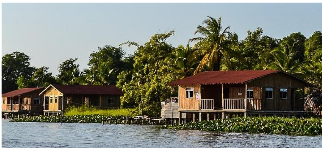
Vivienda Añú con techo y cerramientos de enea. © Gasparini
