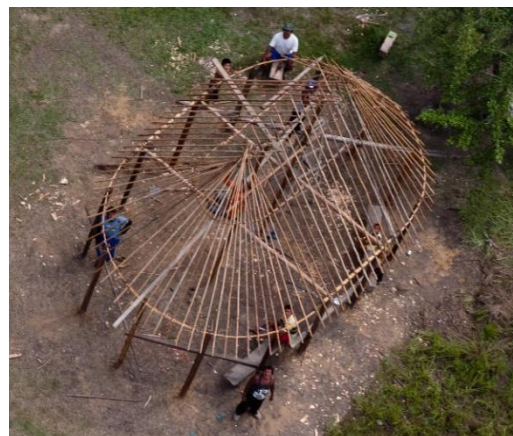
Construcción de churuata con madera rolliza local. Canaima, Estado Bolívar. CC Luis Adolfo Ovalles
