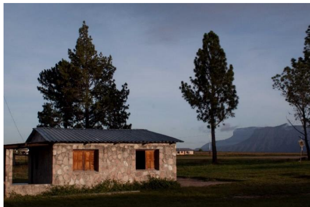
Revestimiento de fachada con enchapado de piedra en vivienda contemporánea. Parque Nacional Canaima. CC Luis Adolfo Ovalle
