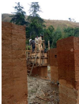
Construcción de tapia. Chacantá, Mérida. CC Venezuelatina
