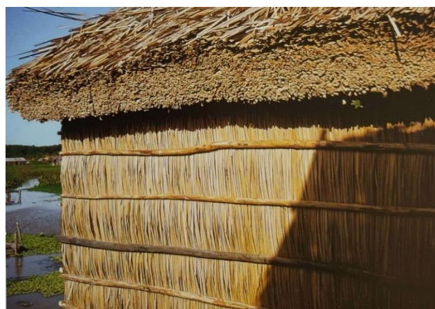
Vivienda Añú con techo y cerramientos de enea. © Gasparini
