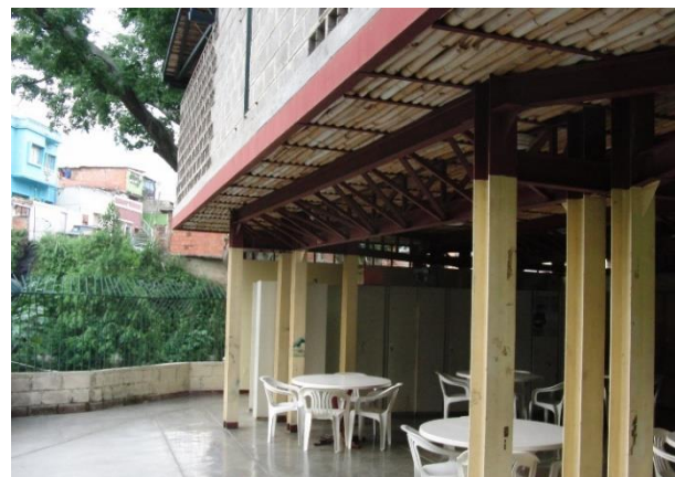
Estructura metálica portante en edificio de Caracas. CC Olga Berrios
