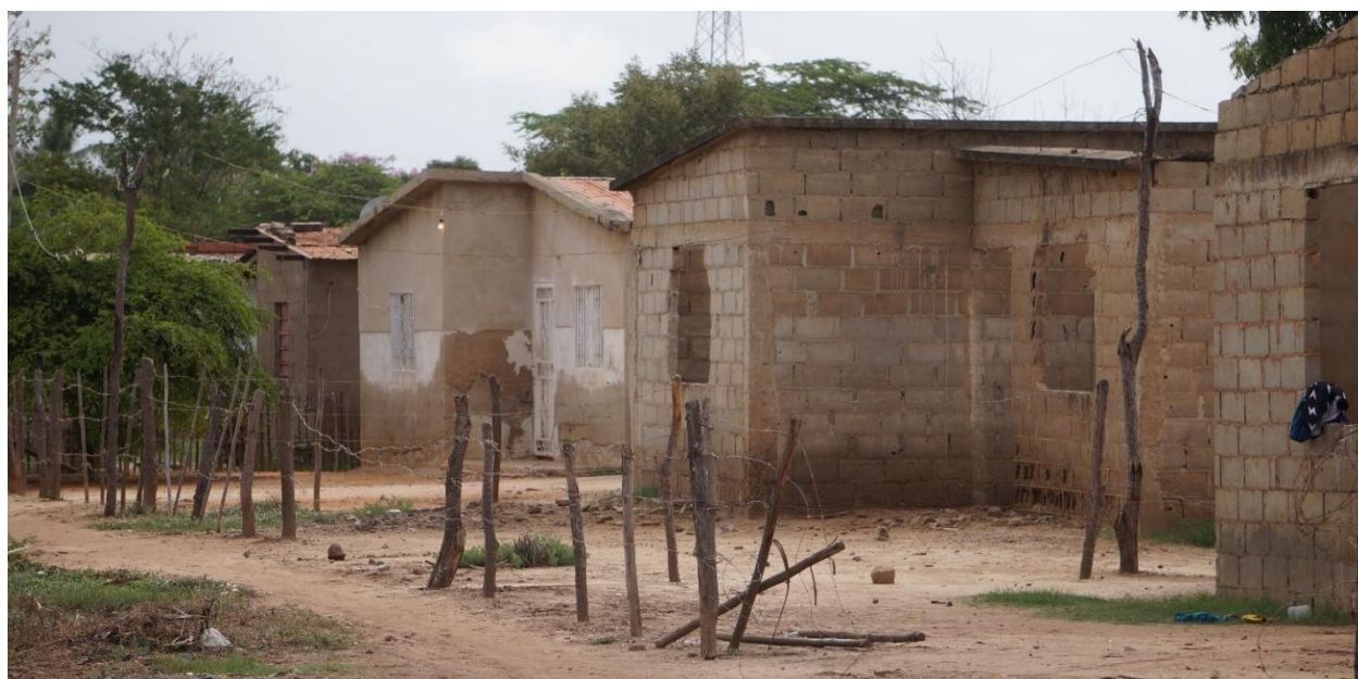
Viviendas de bloque de cemento-arena, con distintos niveles de acabados de cemento, Villa Bolivariana I. CC Fidel Guerrero, TECHO
