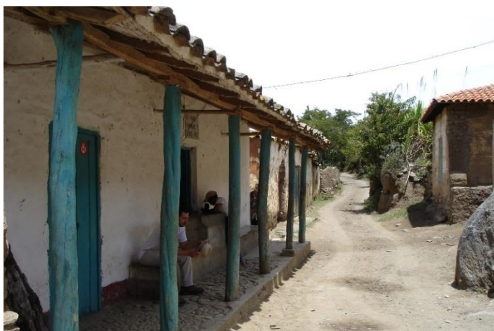
Corredor con horcones de madera rolliza pintada. Los nevados, Mérida. CC Queenstown local
