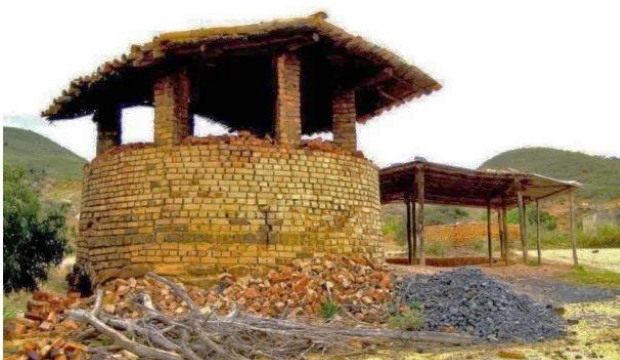
Horno tradicional para la producción artesanal de ladrillos. Lobatera, Estado Táchira. CC Kevin Vásquez
