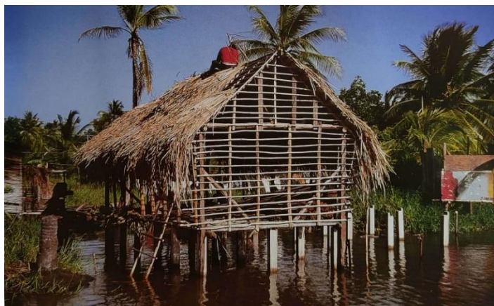
Construcción de vivienda Añú con madera rolliza local de distintas secciones y características. © Gasparini
