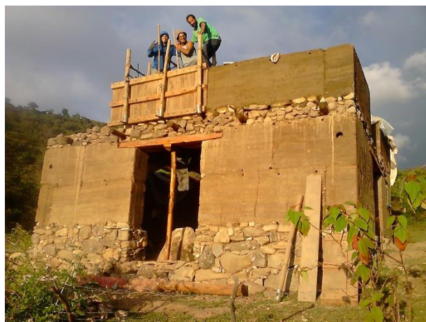
Construcción de tapia pisada. La Mucuy, Santos Marquina, Mérida. CC Daniel Velásquez, Fundación Senderos
