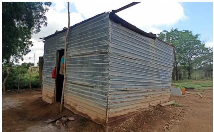
Vivienda informal con cerramientos de lámina metálica reciclada. Mara, Zulia. CC Jessica Moreno, TECHO
