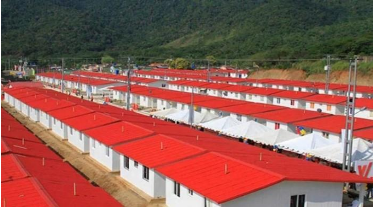
Construcción de urbanización de viviendas con materiales plásticos en cubiertas, cerramientos y carpinterías. Ejecución llevada a cabo por la empresa Petróleos de Venezuela Sociedad Anónima (PDVSA), Petrocasa - © Petrocasa
