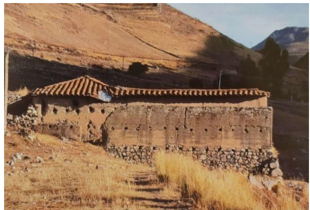
Construcción de tapia con sobrecimientos de piedra. Apartadero, Estado Mérida. © Gasparini
