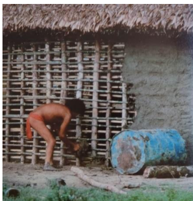
Embutido del bahareque en churuata Ye'kwana. Frechione
