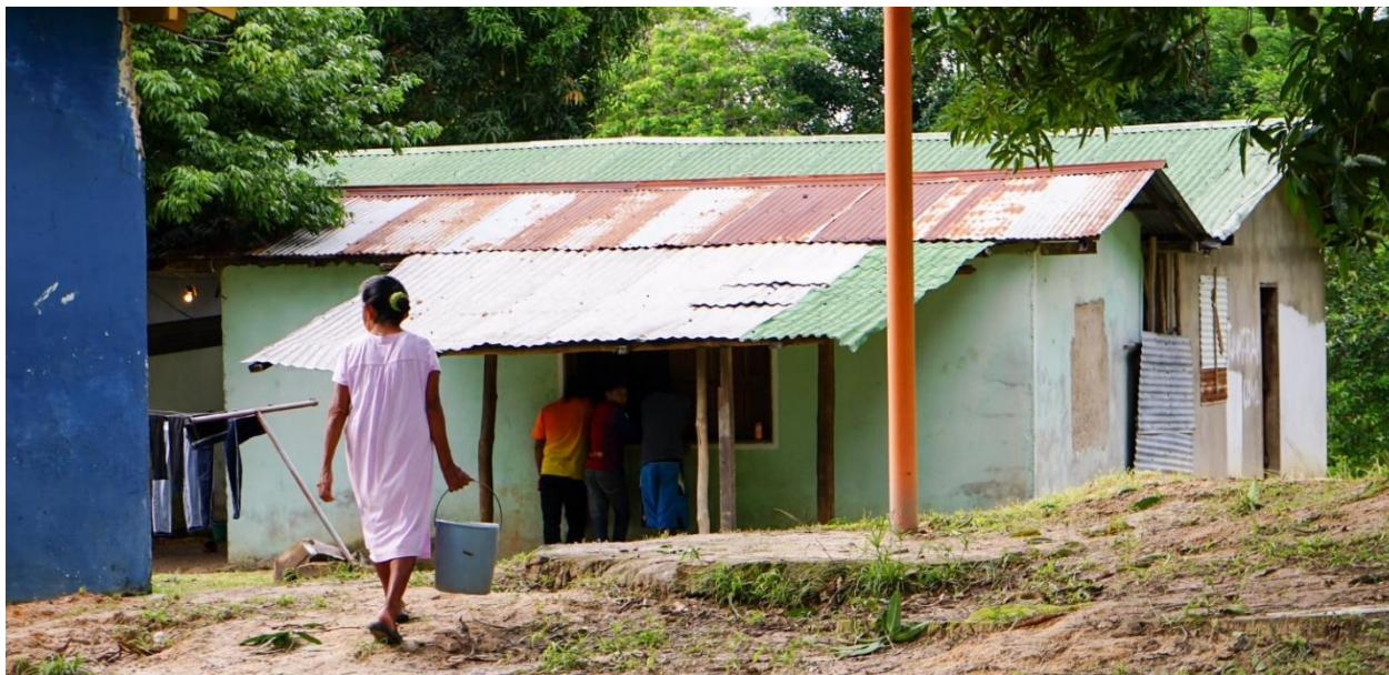
Cubiertas de láminas metálicas con distintas calidades y estado de conservación. CC Tomscoffin
