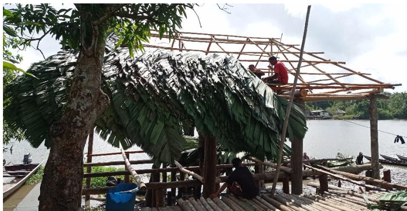
Construcción de un techo vegetal con palma local. Nina Hurtado, Asociación Nilo
