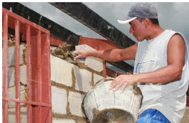
Auto-construcción de muro de bloques de cemento-arena. © GMVV
