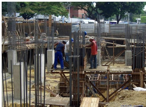
Construcción de concreto en Caracas. CC Rufino Uribe
