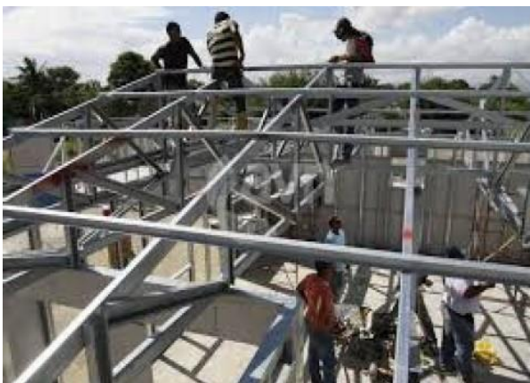
Estructura de techo con perfiles metálicos. CC Photo RNW org
