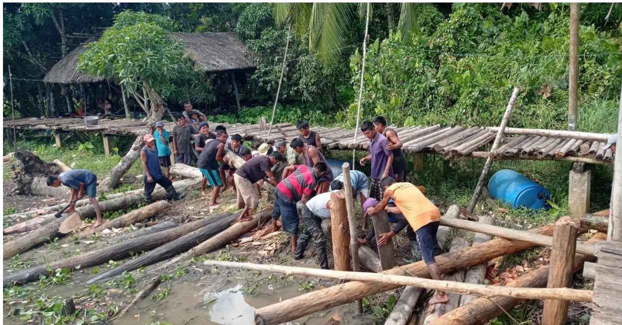
Construcción colectiva en asentamiento Warao con horcones de madera rolliza local. Delta Amacuro. CC Nina Hurtado, Fundación Voces Libres
