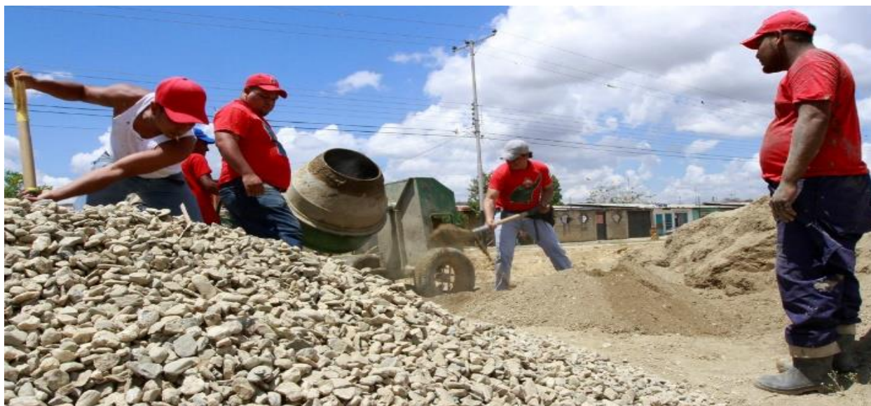
Trabajadores elaborando mezcla de concreto con grava, arena y cemento. © Construpatria, GMVV
