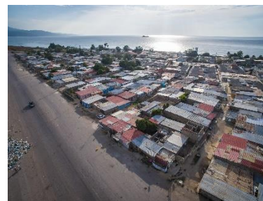
Cubiertas de lámina metálica generalizadas en barrio de Cumaná, Estado Sucre - CC BID Ciudades Sostenibles
