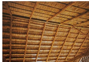
Las viviendas palafíticas tradicionales con mangle y enea tienen una excelente adaptación bioclimática: además de disponibles y abundantes localmente son vitales para los ecosistemas de humedal. Laguna de Sinamaica - Gasparini ©
