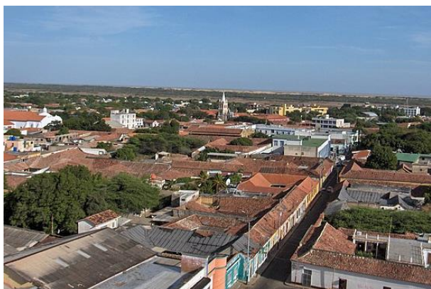
Vista de conjunto del centro histórico de Coro — CC Pedro Marcan
