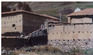
Construcción de tapia con sobre-cimientos de piedra. Apartadero, Est. Mérida – Gasparini ©
