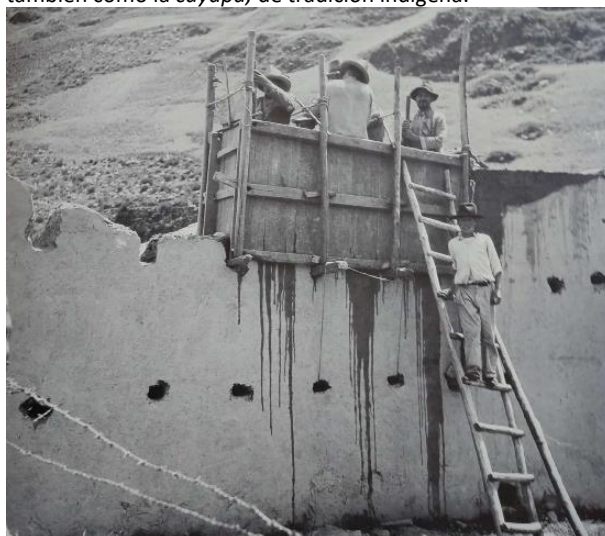
Fotografía histórica (años 1950) con los “pisoneros” dentro del encofrado y el “zurronero” subido a la escalera. San Rafael de Mucuchíes, Estado Mérida – Gasparini ©
