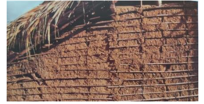
Pared de bahareque con envarillado de caña y sin empañetar. Caturo, Estado Sucre – Gasparini ©
