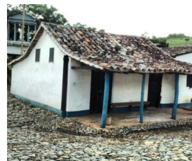
Canales de drenaje y ligeras pendientes empedradas para alejar el agua de escorrentía de la vivienda. Táchira - CC Quilverd Arias Camargo
