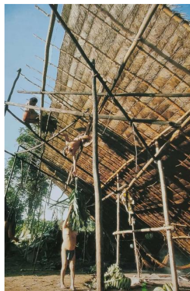
Proceso constructivo del shapono - Napoleón Chagnon ©
