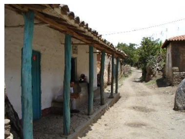
Corredor con techo de teja, un espacio de estar sombreado y ventilado. Los Nevados, Estado de Mérida - CC Queenstown Local
