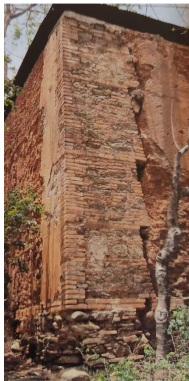
Rafa de mampostería de ladrillo cocido para reforzar la esquina del edificio de tapia – Gasparini ©
