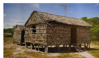
Vivienda palafítica con techo de lámina. Delta Amacuro - CC Gosia Malochleb
