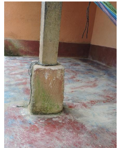
Horcón sobre pedestal de concreto en corredor - CC Leo Javiex
