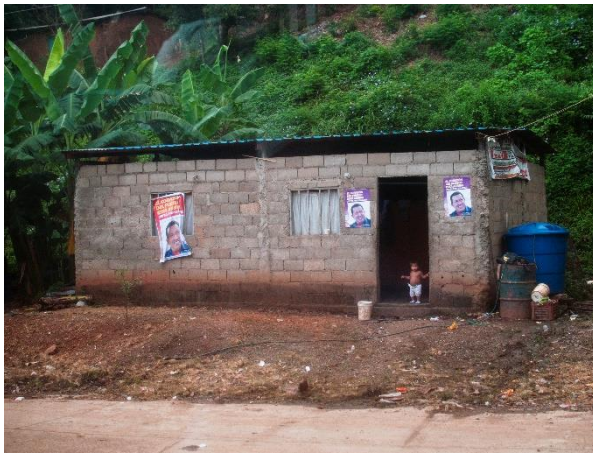
Vivienda de bloque cemento-arena. Estado de Guárico - CC Eduardo Regalado
