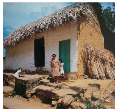
Rancho campesino con pronunciada cubierta vegetal y umbral de entrada elevado para protegerse de la lluvia y las posibles inundaciones – Gasparini ©
