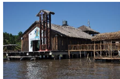
Iglesia sobre el agua inspirada en la cultura constructiva local. Laguna de Sinamaica, Estado Zulia - CC Maga Soto
