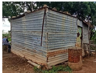
Grandes piedras sobre el techo ayudan a mantenerlo techo en caso de fuerte viento. Mara, Estado Zulia – CC Jessica Moreno, TECHO
