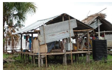
Vivienda palafítica con techo de lámina. Delta Amacuro - CC Gosia Malochleb
