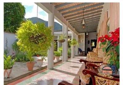
Corredor con cielo-raso de caña - CC Keenan Miranda
