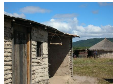
Viviendas de bahareque construidas con materiales locales gratuitos o de muy bajo coste - CC jmalдона
