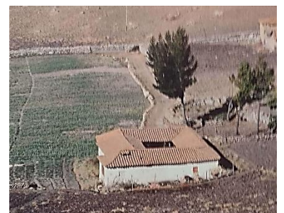
Vivienda introvertida, protegida por espesos muros perimetrales con escasas aberturas, para resguardarse del frío de los páramos. Organizada alrededor de un patio central que colecta el calor y lo distribuye al interior. Cubiertas de teja aislantes. Estado de Mérida – Gasparini ©
