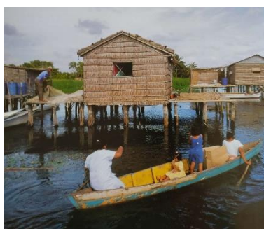
Vivienda Añu con plataforma exterior filtrante, útil para distintas actividades cotidianas como la preparación de las redes de pesca o el secado de productos - Gasparini ©
