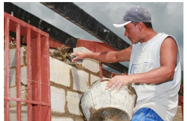
Albañil trabajando en la construcción de un cerramiento con bloque de cemento-arena — Gran Misión Vivienda Venezuela ©
