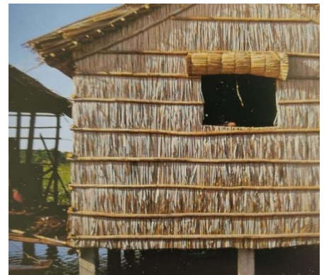
Detalle de cerramientos de enea - Gasparini ©
