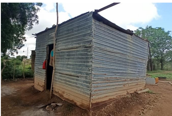
Pequeño rancho de lámina metálica reciclada. Mara, Zulia — CC Jessica Moreno, TECHO
