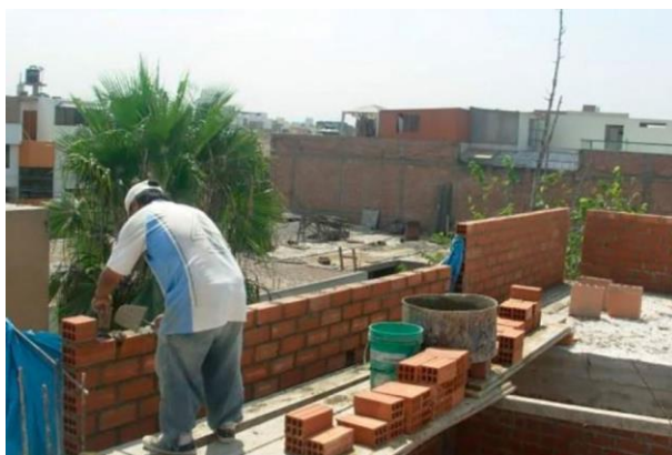
Auto construcción con ladrillos cocidos — CC Wikimedia
