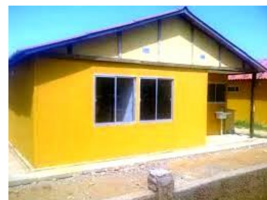
Vivienda social rural de la GMVV con materiales industriales (estructura metálica, cerramientos de conglomerados, plástico PVC, etc) altamente contaminantes en su producción - Contreras Miranda ©
