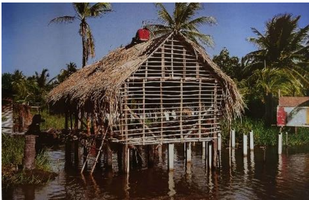
Vivienda tradicional Añú en proceso de construcción – Gasparini ©
