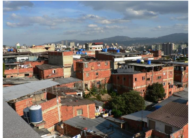
Viviendas de varios niveles de ladrillo cocido confinado en estructura de concreto. Caracas – CC RNW org
