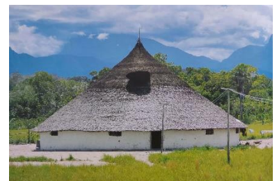
Ventana cenital de la churuata ye’kwana que favorece la ventilación. Comunidad de la Culebra - CC Paolo Gasparini
