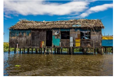
Vivienda palafítica híbrida construida parcialmente con materiales industriales de recuperación que aportan un segundo uso a productos considerados de desecho - CC Jogleher
