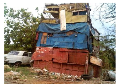
Rancho construido con materiales reciclados o de desecho en muy mal estado - CC Wilfredorh
