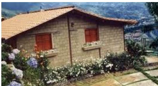
Viviendas de bloques de tierra compactada (BTC) fruto del convenio ULA-CONICIT-MSAS. Paramo de río Chama, Edo. de Mérida – © Contreras Miranda
