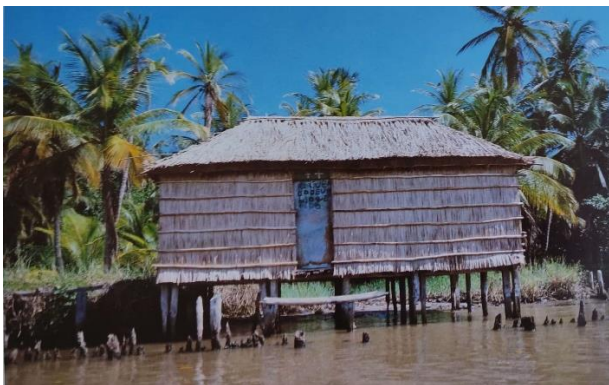
Palafito endógeno Añú de mangle y enea – Gasparini ©
