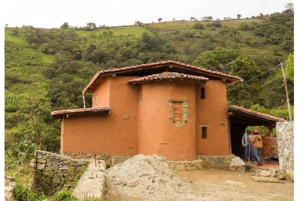
Vista de conjunto en el estado actual de la obra (agosto 2022) con fachadas empaquetadas - CC Daniel Velásquez, Fundación Senderos
