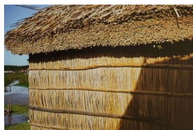
Los cerramientos y techos de enea permiten filtrar aire para refrescar el interior de la vivienda Añu - Gasparini ©
