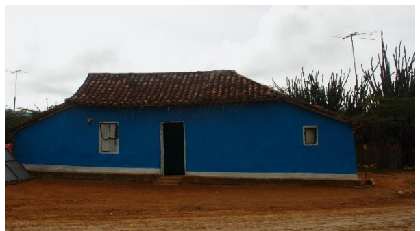
Casa de bahareque con techo a cuatro aguas de teja - CC Wilfredorh
