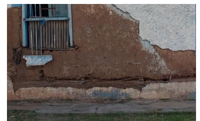
Estructura de bahareque apoyada sobre un pequeño sobre-cimiento (o cepa ) para proteger la pared de la humedad del suelo. Isla Margarita - CC Wilfredorrrh
