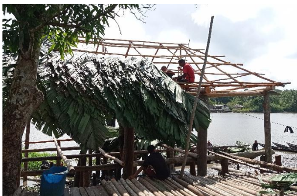
Colocación de un techo vegetal de palma por maestro local y sus ayudantes. Delta Amacuro – CC Nina Hurtado, Asociación Nilo
