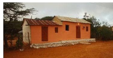
Casa de hato con techo de lámina metálica, especialmente inapropiada en la región por los fuertes vientos que generan mucho ruido en el interior. Estado Falcón - CC R Barraez D Lucca
