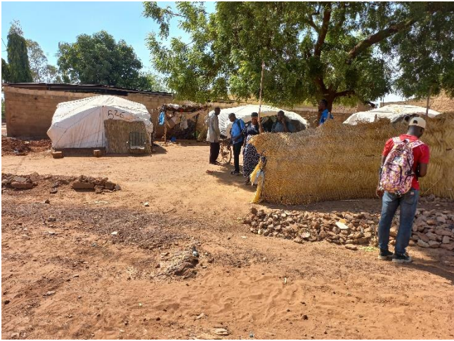
Ménage de PDI dans un terrain en ville. La clôture est en cours de construction avec des nattes de fibres végétales tissées
