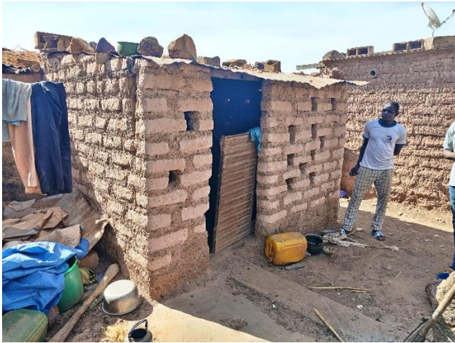
Cuisine avec ventilation
