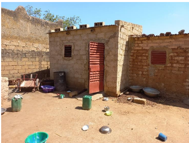
Chambre construite en parpaings de ciment
