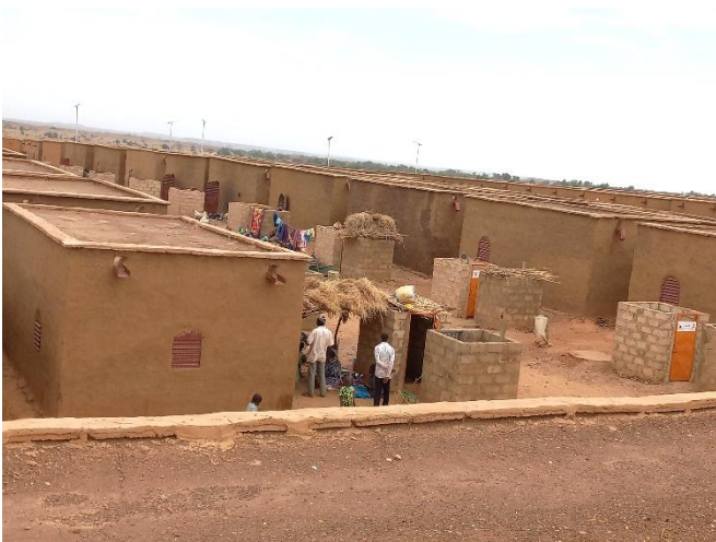
Abris avec des latrines / douches et sans cour construits pour les PDIs
