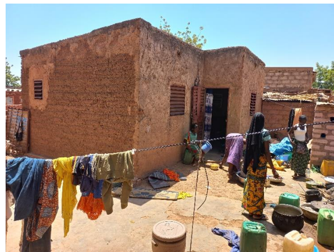
Chambre construite en banco
