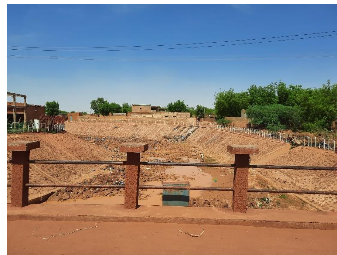
Un cours d'eau canalisé à Kaya
