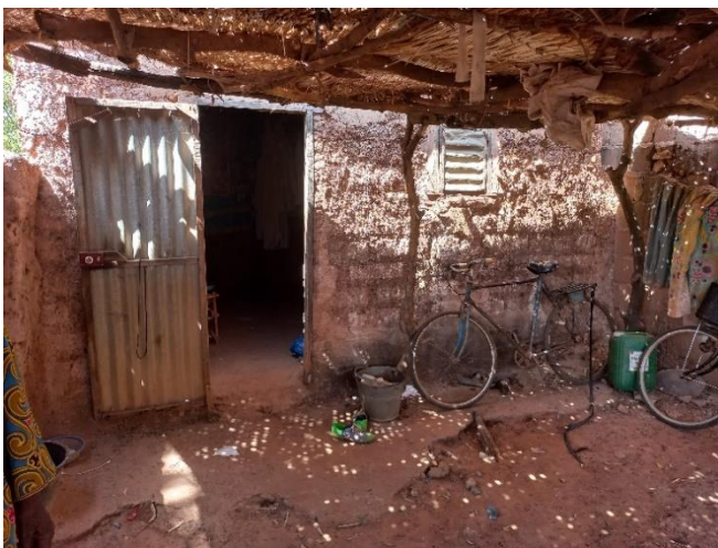
Hangar extérieur couvert
