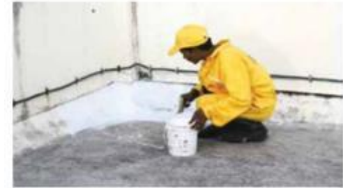
a. Applying the primer
