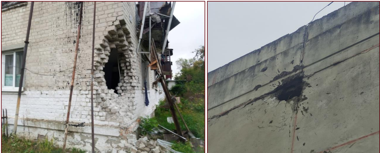
Рисунок 7 – Пошкодження, спричинені прямим влучанням снаряда, зокрема уламками від вибуху, с. Покровське (зліва) та м. Харків (справа), джерело https://dream.gov.ua/
