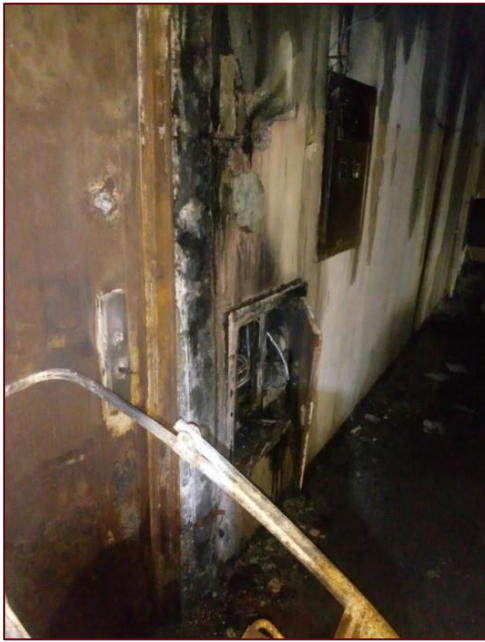
Рисунок 6 - Електричні щити з явними ознаками обгорання та пошкодження в результаті пожежі. Багатоквартирні будинки, м. Харків (зліва), джерело https://dream.gov.ua/ , м. Київ (справа), фото Миколи Тимченко (джерело https://rubryka.com/ )
