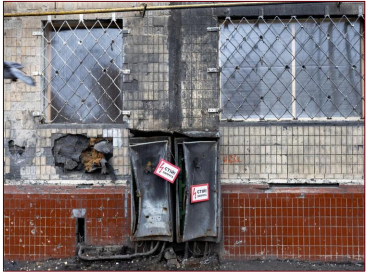
Рисунок 6 - Електричні щити з явними ознаками обгорання та пошкодження в результаті пожежі. Багатоквартирні будинки, м. Харків (зліва), джерело https://dream.gov.ua/ , м. Київ (справа), фото Миколи Тимченко (джерело https://rubryka.com/ )
