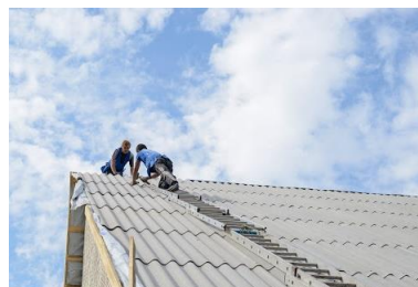
Рис. 29 - Покрівельний матеріал, що не містить азбесту. Організація «Людина в біді», м. Слов'янськ, 2016 р. Фото Р. Луніна
