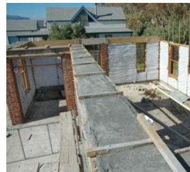
Рис. 26 - Верхня несуча балка з монолітного бетону; варто звернути увагу на те, що бетонний каркас поки що не демонтовано
