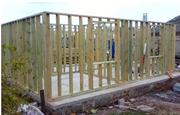
Рис. 25 - Стіна з дерев'яним каркасом за зразком північноамериканського дерев'яного каркасу з балками на подушці. Варто звернути увагу на те, що щільно розташовані дерев'яні стійки каркасу зібрані як панель несучої конструкції (м. Слов'янськ, «Добра новина», 2015 р.)
