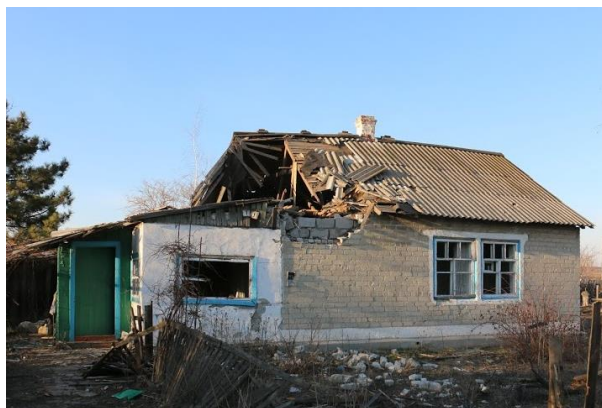
Рис. 40 - Кладка з бетонних блоків та обпаленої цегли за оцінками організації «Людина в біді» у с. Нікішино, 2015 р. Фото Р. Луніна
