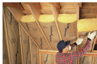
Рис. 32 - Ізоляція вздовж схилу даху, потрібно передбачити більше деталей у випадку використання парової фольги або паронепроникної плівки, проте об'єм під ними придатний для використання.
