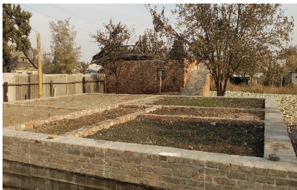
Рис. 16 - Повторне використання наявного фундаменту для реконструкції. Варто звернути увагу на те, що фундамент під стіни у чудовому стані і не потребує бетонування нижньої кільцевої балки. Підлога не встановлена. (Проект Адвентистського агентства допомоги та розвитку, м. Слов'янськ, 2015 р.)
