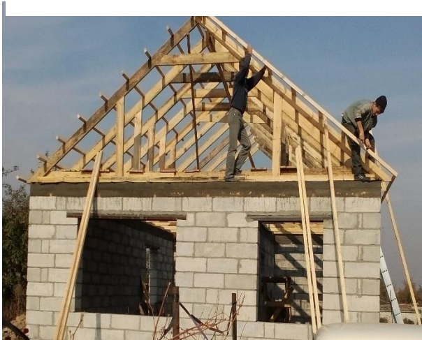
Рис. 24 - Бетонна кладка (м. Слов'янськ. Адвентистське агентство допомоги та розвитку, 2015 р.)
