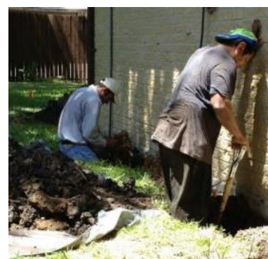
Рис. 14 - Перевірка викопаної стовпової ями
