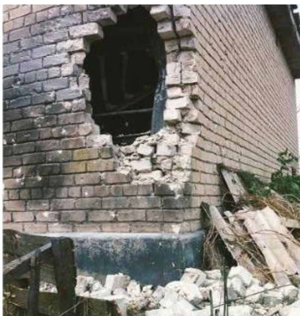
Рис. 7 - Наслідки прямих попадань малокаліберної зброї, які можна виправити за допомогою відповідних технік
