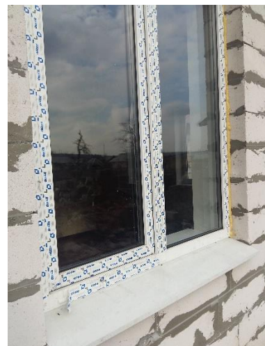
Рис. 22 - Вікна; варто звернути увагу на те, що ізоляційна піна вздовж рами і зовнішнього підвіконня виступає для захисту стіни. (Червоний Хрест Люксембургу, м. Слов'янськ, 2015 р.)
