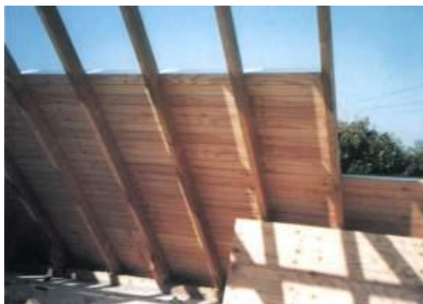
Рис. 39 - Сендвіч-панелі використовуються замість планки перекриття, ізоляції, гідроізоляції та стелі, що особливо важливо при наявному доступі до горища.
