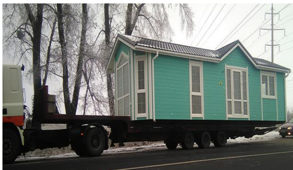
Рис. 13 - Приклад виготовлення збірних конструкцій, 45 м.кв., 10 000 дол. США. Одиниця перевозиться як повний будинок і встановлюється за допомогою крану. «Добра новина», 2016 р.
