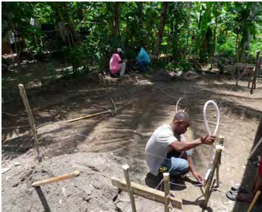
Mise à niveau des chaises à l'aide d'un tuyau à eau transparent
