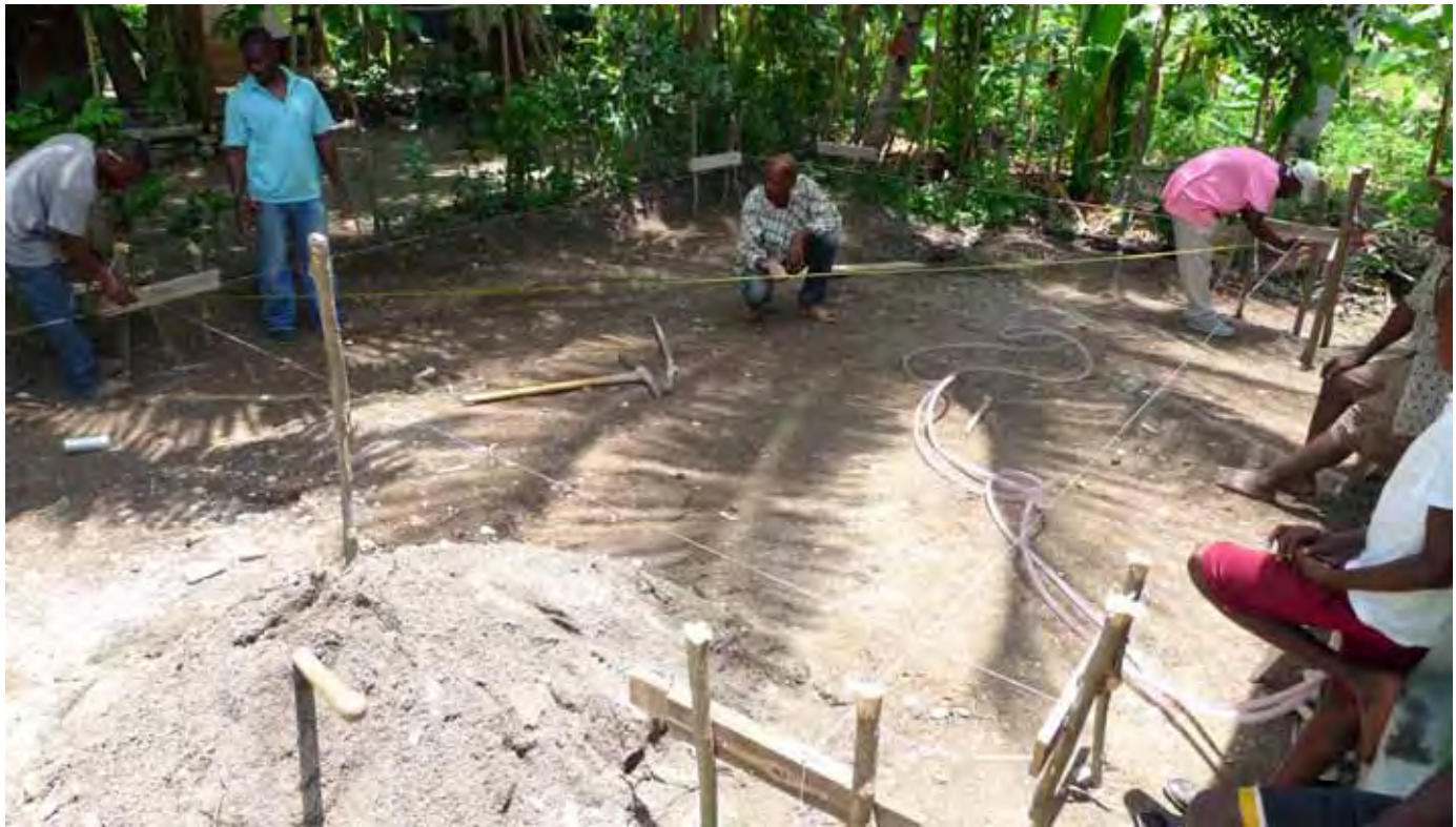
Vérification des diagonales
