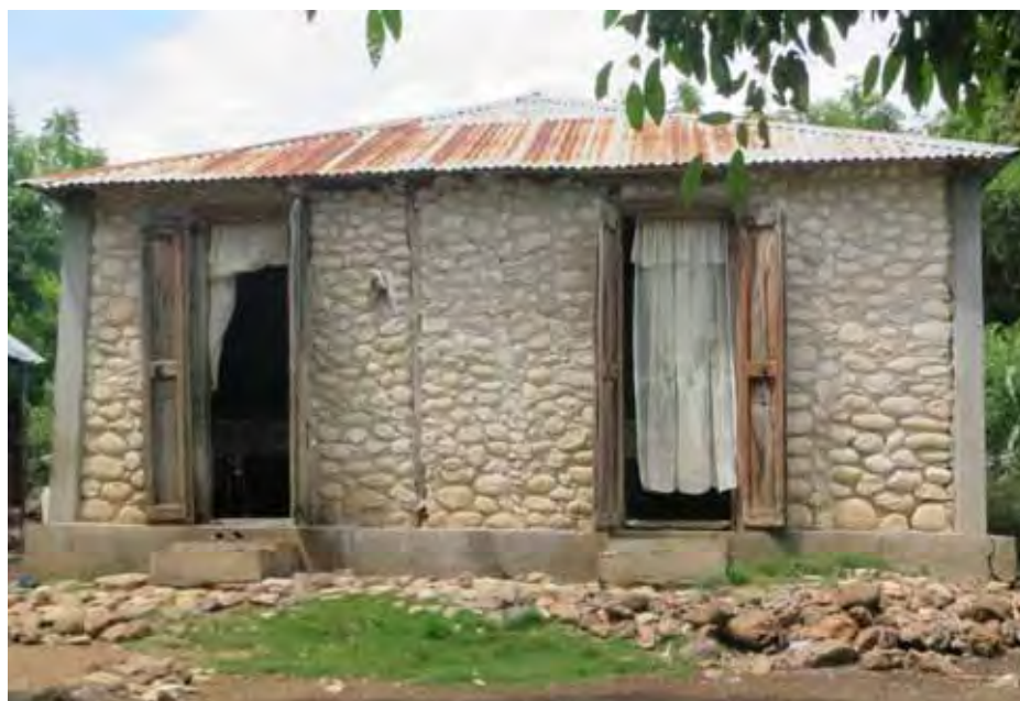
Remplissage en maçonnerie de galets, de galets taillés ;
