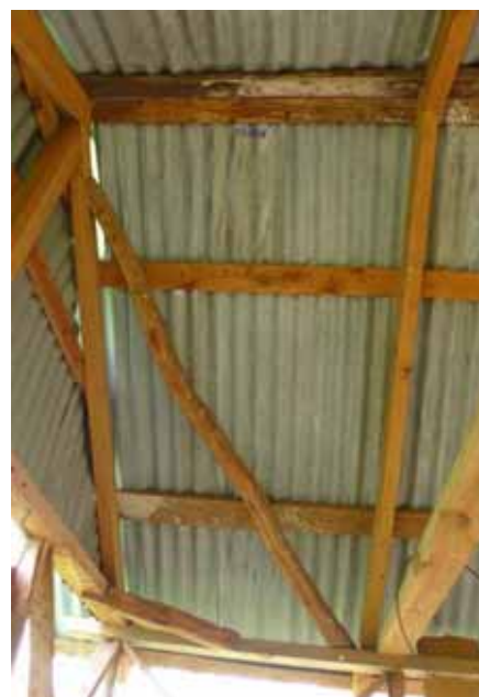
Type de contreventement traditionnel en Haïti
