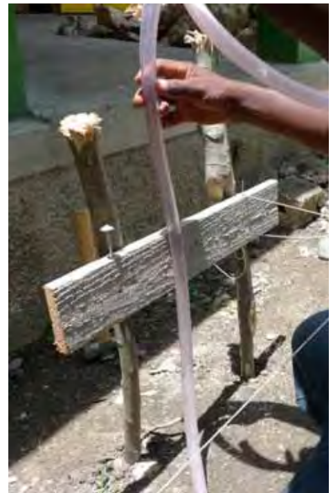
Mise à niveau des chaises à l'aide d'un tuyau à eau transparent
