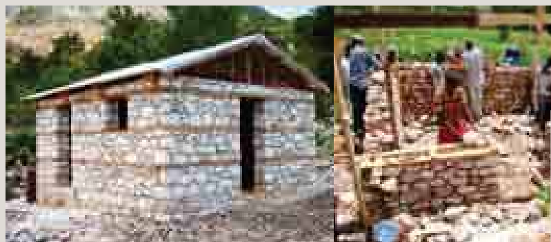
Ci-dessous, les modèles proposés dans les zones montagneuses du projet ENH-PRESTEN sont en maçonnerie de pierre chaînée par des échelles de bois horizontales disposées tous les 60 cm
