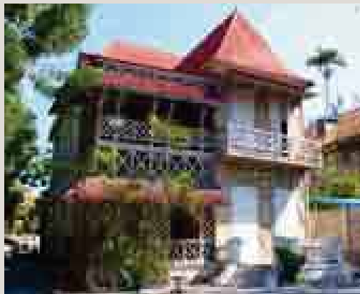
Modèle de gingerbread, architecture urbaine en ossature bois et remplissages divers (terre, pierres, briques) et ou bardage. Le comportement de ces constructions face au séisme a été remarquable
