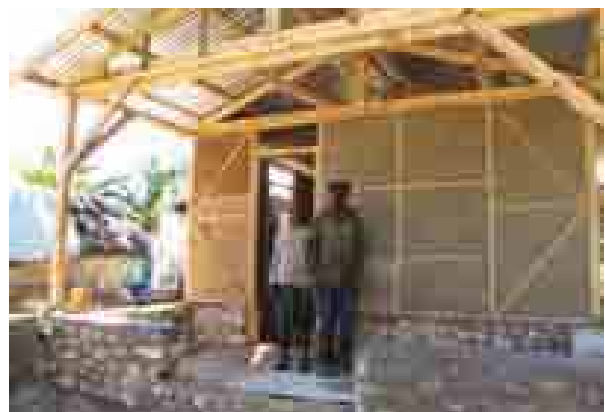
Ci-dessous, exemples de maisons à ossature bois et remplissage en briques de terre moulée
