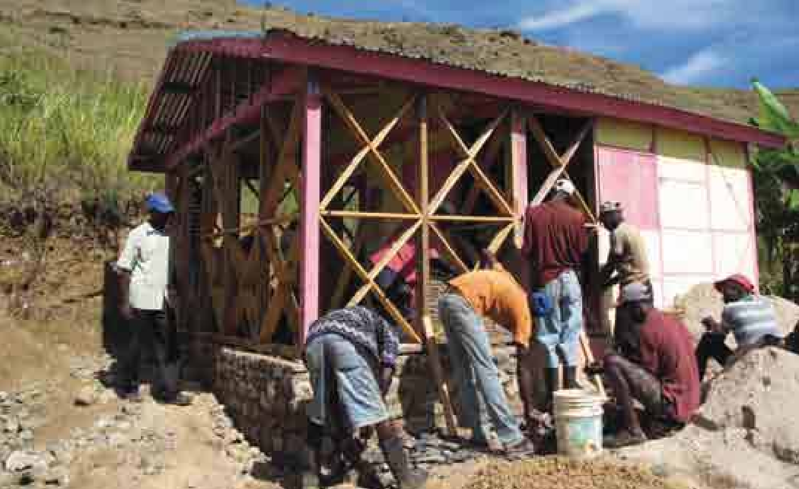
Ci-dessus, chantier formation à Belle Fleur, sur une maison à ossature bois et remplissages ti-woch et briques crues
